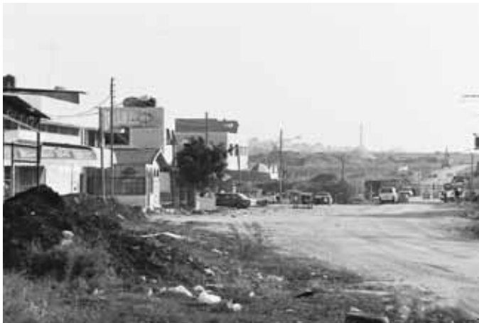
Die Einkaufsmeile zerstört
