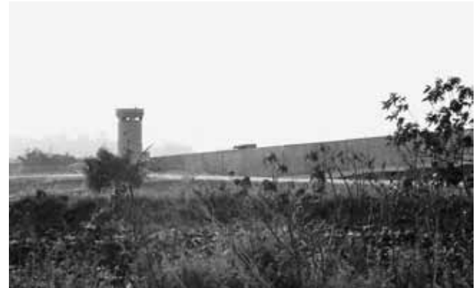
Im westlichen Teil des Distrikt Jenin wurden, um ein Beispiel zu nennen, 18 km 2 Land konfisziert und mit der Mauer abgegrenzt. Auf diesem Land stehen heute die
